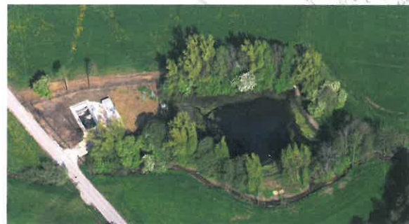
Luftaufnahme Pumpstation und Regenüberlaufbecken
