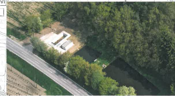
Luftaufnahme Pumpstation und Regenüberlaufbecken
