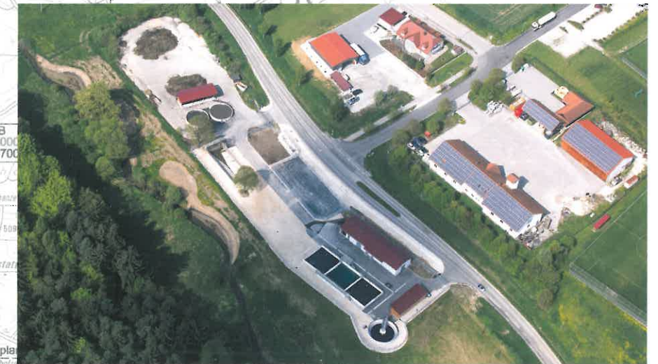
Luftaufnahme neue Kläranlage Gerolsbach
