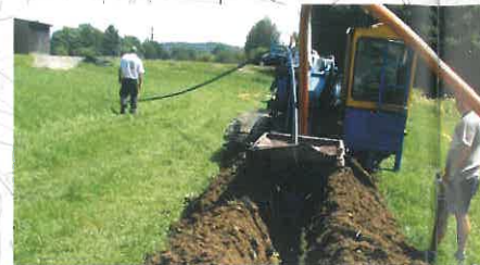
Verlegung der Leitungen zwischen den Ortsteilen
