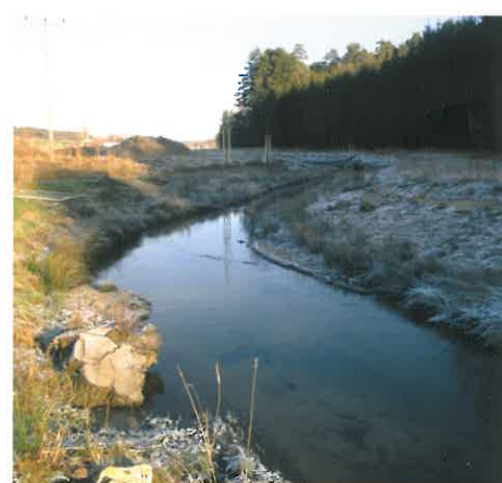
Mai 2011 Baubeginn mit der Verlegung des Gerolsbaches.
