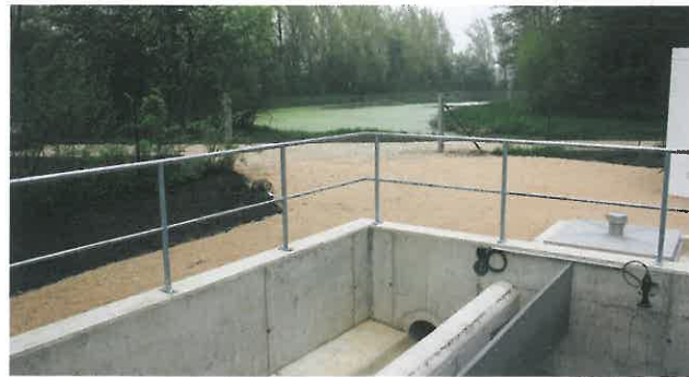
Regenüberlaufbecken mit Blick auf Schönungsteich (ehemaliger Klärteich)
